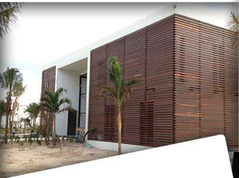
■ OBRAS: CLUB DE PLAYAS Y PUENTES CANCÚN, QUINTANA ROO, MÉXICO
